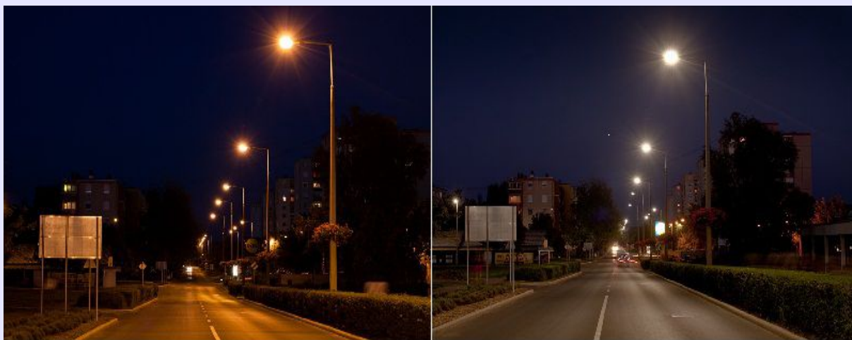
3. kép: Kaszap utca, a nátriumlámpást felváltó LED világítással (© Hódmezővásárhely, Tungsram-Schröder)
