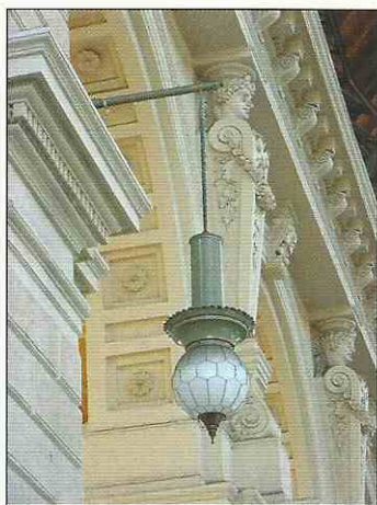
A Keleti pályaudvaron 1884-ben felszerelt Zipernowsky-féle ívlámpa formai megjelenítése az 1998-as rekonstrukció során
