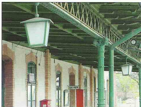
Angyalföld állomás előtető-világítása az 1994-es rekonstrukció után
