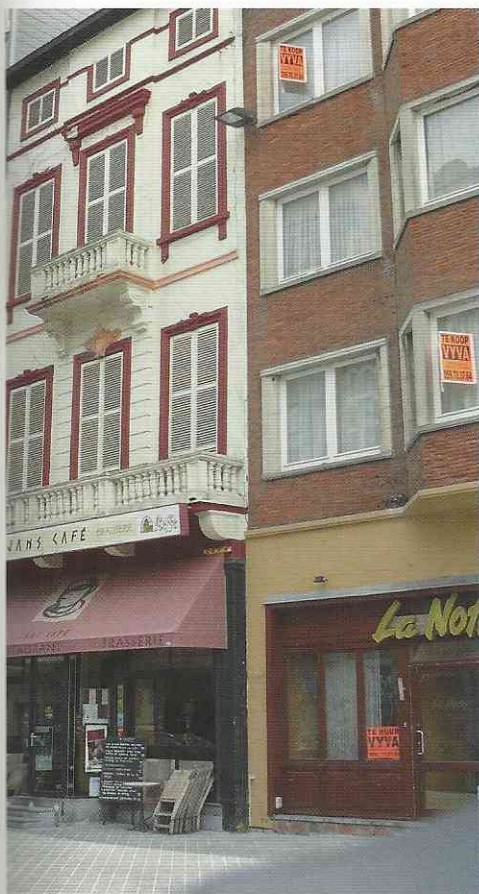
3. kép Fényvetős közvilágítás, Oostende
