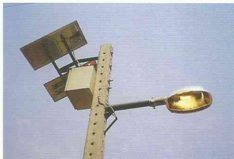
3. kép Közvilágítási lámpa Asuncion 2x10W DS10, 1x7W Steca CFL, és 20Ah akku.
